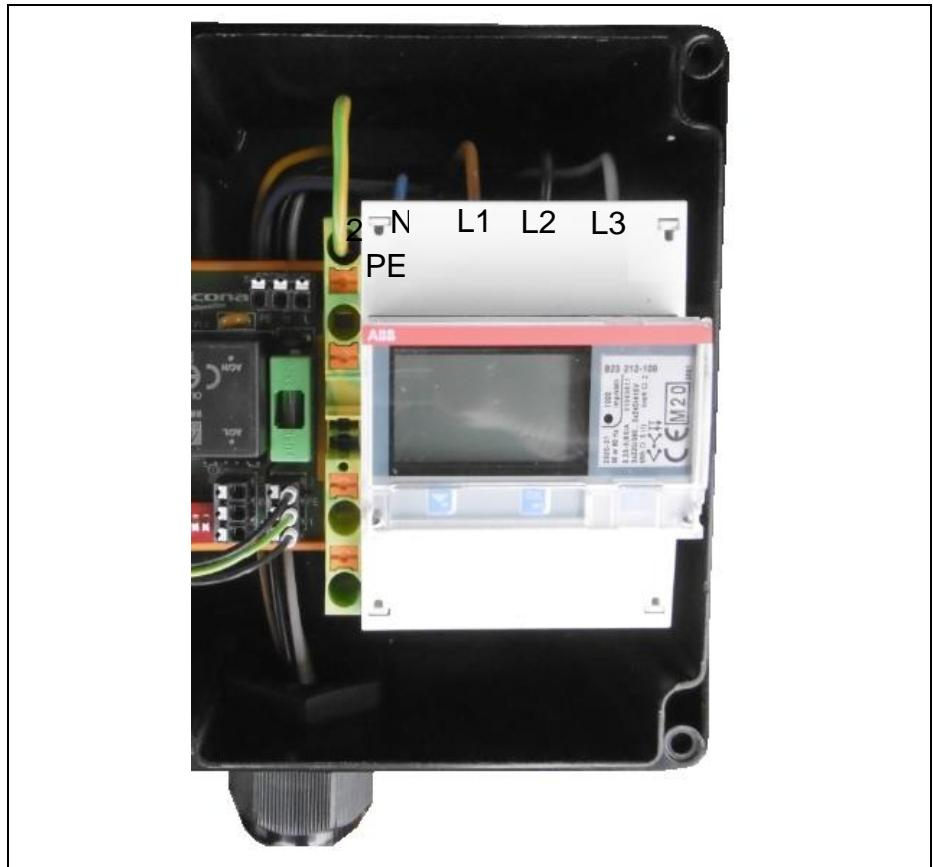
Die Zuleitung wird von unten durch die M32 Kabelverschraubung eingeführt. Die Adern sind hinter dem Laderegler nach oben zu führen. Der PE-Anschluss erfolgt an der grün-gelben Klemme. Die drei Phasen und der Neutralleiter werden direkt von oben am Energiezähler angeschlossen.
